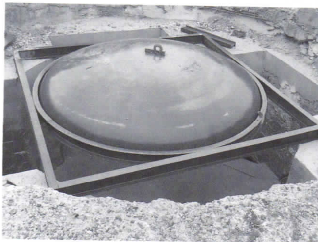
Le plafond de l'étage supérieur de la tourelle est posé.
