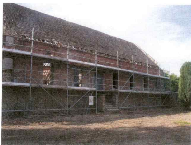
Ferme du Centre : Sablage et rejointoyage de la façade - Préparation de la dalle à l'étage
